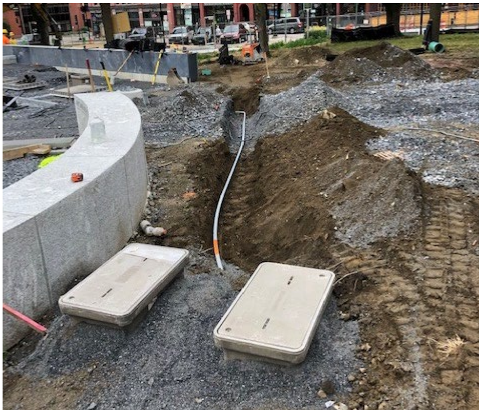
Wi-Fi Conduit to NW Ellipse LPB
